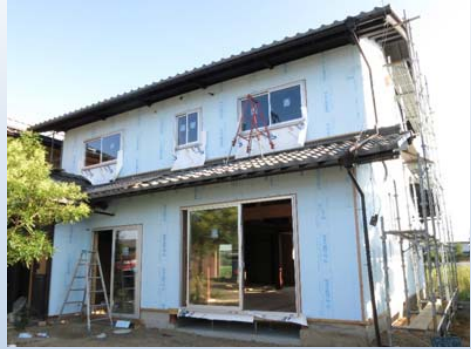
断熱材の設置
