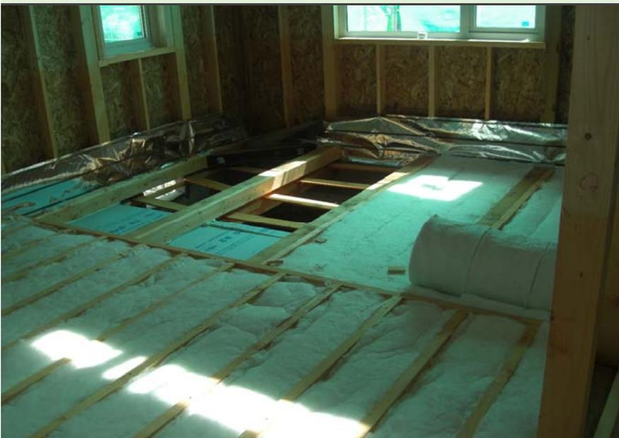
床断熱材の施工 高性能GW16k100+50<sub>ミリ</sub>
